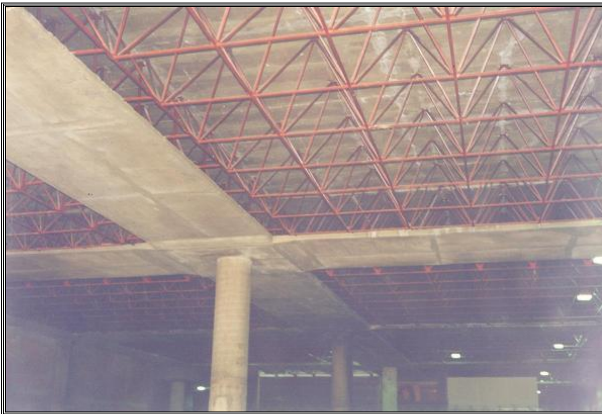
Fig. 2. 2. Tridilosa
