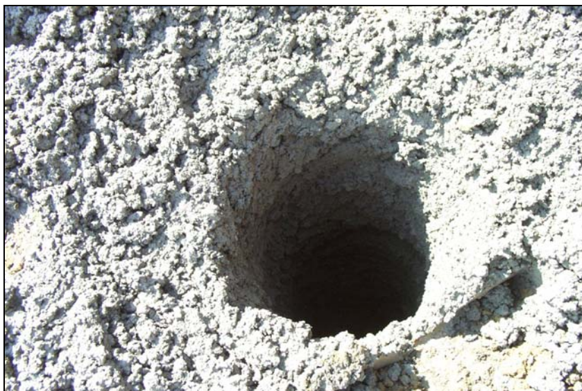
Figura V.9 Inclusión recién terminada
