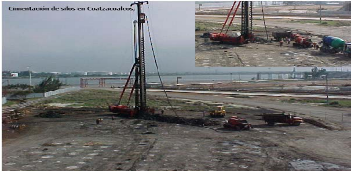
Figura V.26 Ejemplos de aplicación del equipo Starsol
