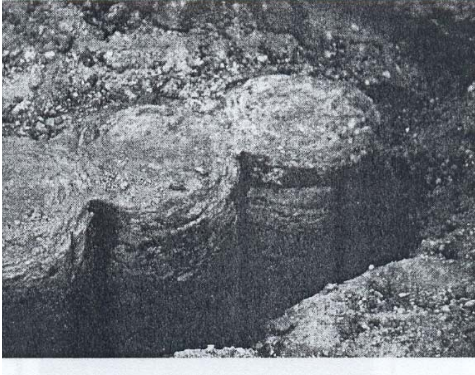
Figura IV.5 Columnas de Cal cemento mezcladas in situ
