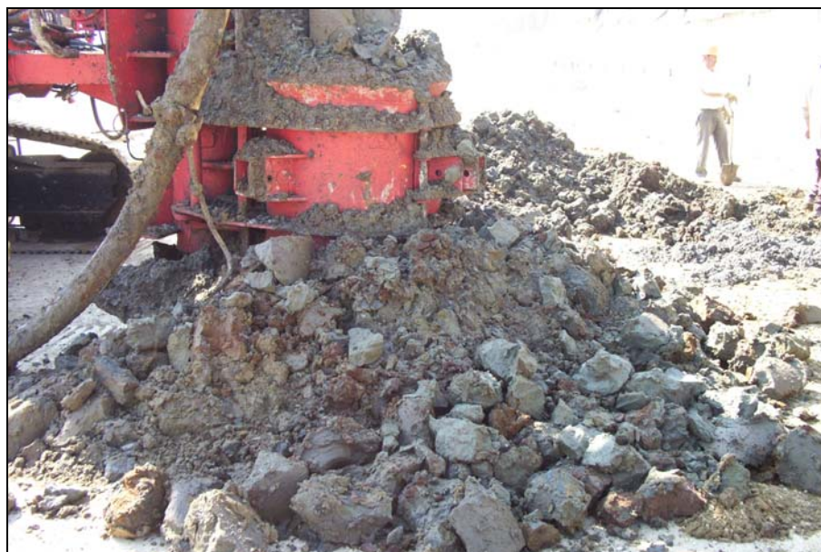
Figura V.7 Vista en la que se aprecia el inicio de la colocación de inclusiones en donde el taladro rotatorio ha comenzado a realizar la perforación
