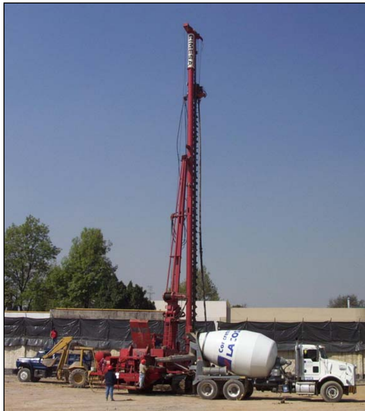
Figura V.5 Posicionamiento del Equipo de Perforación
