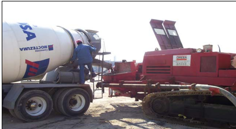
Figura V.6 Vista General de la maquinaria utilizada en el vaciado de la olla a la bomba de concreto
