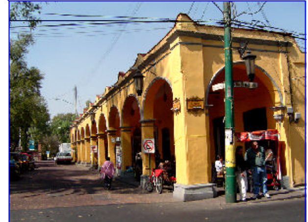
esquina de Madero y Moneda, locales comerciales
