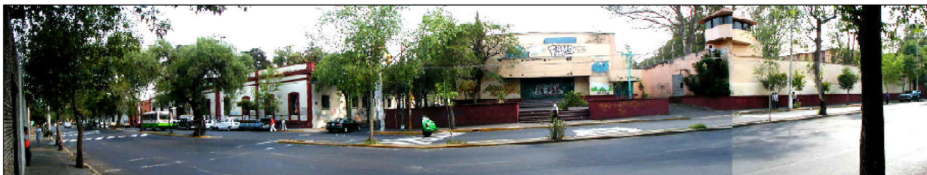
vista de la fachada norte sobre av. San Fernando, 16:00 hrs.
