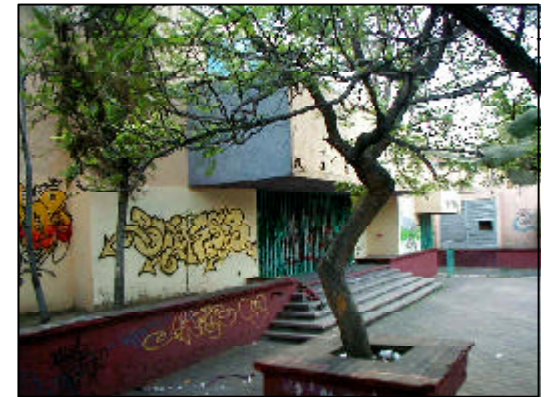
vista No. 2 del acceso; se puede apreciar en todas las imágenes la presencia de basura y graffiti
