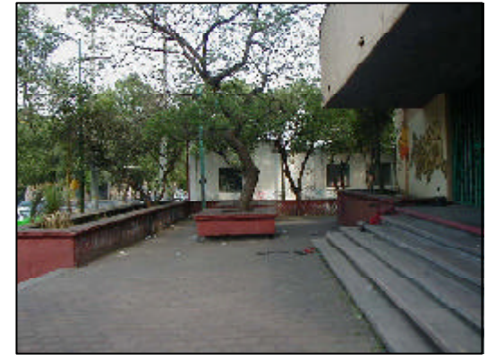
vista No. 1 del acceso
