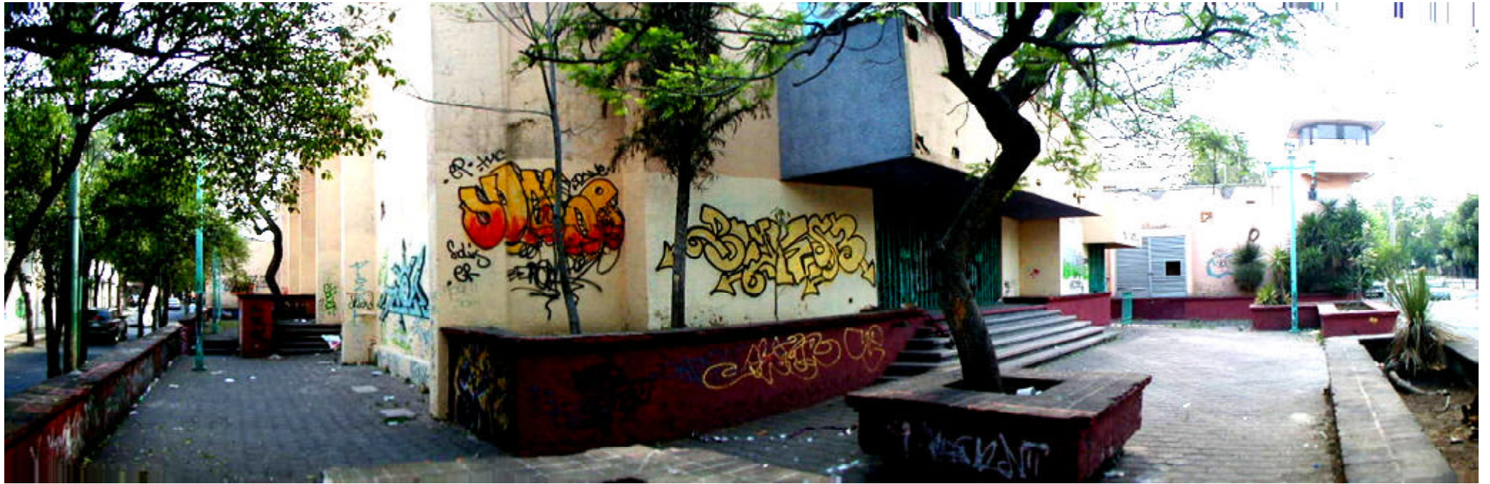
vista desde la esquina de Juárez y San Fernando
