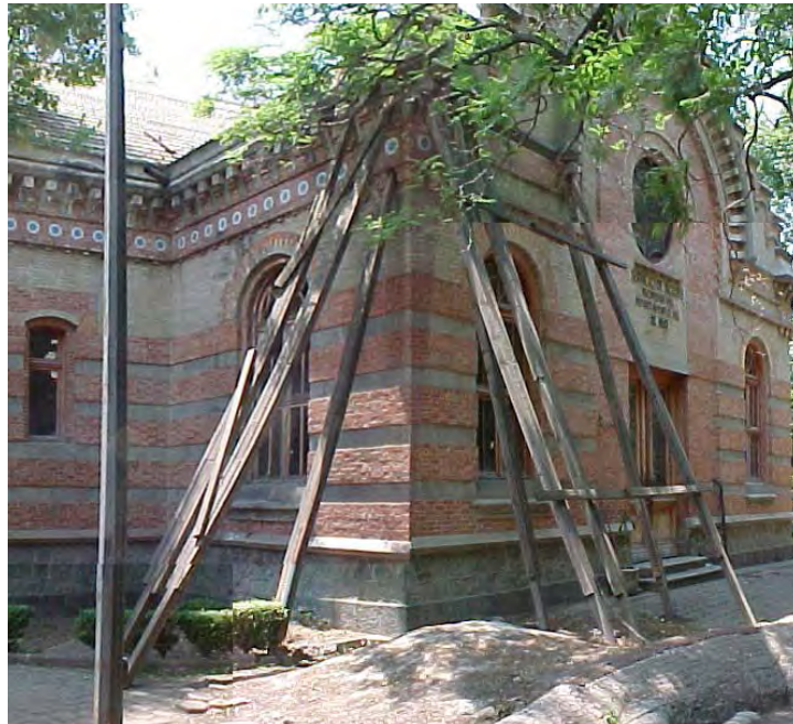
Ilustración 8. El edificio de la antigua casa de bombas, declarado patrimonio histórico, está siendo objeto de obras con el fin de rehabilitarlo.
