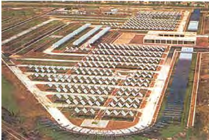
Ilustración 19. Vista del proyecto antes de ser ocupado
