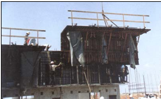
Fig. # 58. Métodos Prefabricados. "OUTINORD" Imagen tomada con fines académicos de: Sistemas Estructurales Aplicados A La V.I.S.
