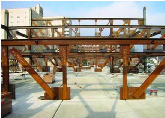
Fig. # 90. Tablero Vierendeel dentro de celosía.
