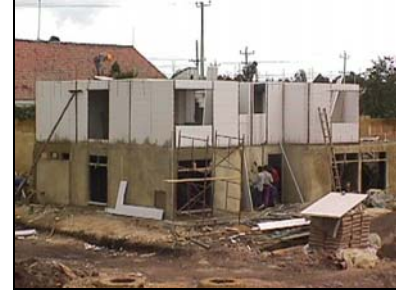
Fig. # 55. Paneles De Poliuretano Con Malla Electrosoldada: 3D PANEL. Imagen tomada con fines académicos de: Sistemas Estructurales Aplicados A La V.I.S.
