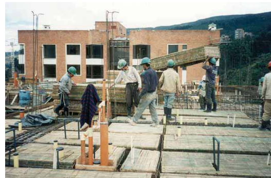
Fig. # 33. Entpiso aligerado en una dirección con casetón de guadua
