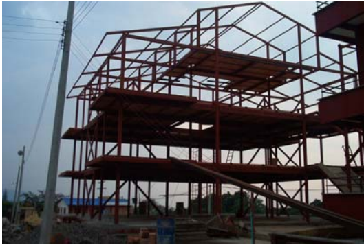
Fig. # 26. Proyecto Habitacional en la Mesa, Cundinamarca, Colombia. 2002 Constructor: Tubos Colmena. Descripción: Estructura Liviana con Perfiles Estructurales. Reproducción fotográfica con fines académicos tomada de: Andrés García
