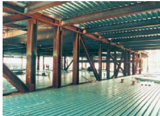
Fig. # 91. Doble abertura Vierendeel dentro de celosía.
