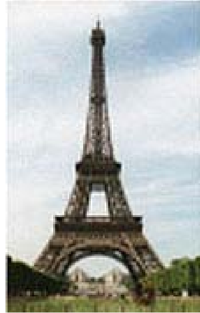
Fig. # 6. Torre Eiffel. Gustave Eiffel 1889. Imagen tomada con fines académicos de: www.structurae.de
