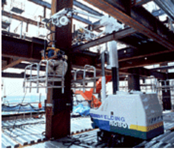
Fig. # 78. Robot soldador. Imagen tomada con fines académicos de: Development of a Robotic Structural Steel Placement System http://www.bfrl.nist.gov/
