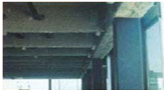
Fig. # 43. Perfiles tubulares relleno de concreto.
