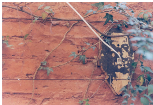
Fig. 3 Detalle de la instalación exterior. 2003
