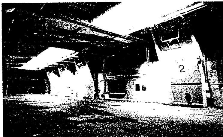
Figura 5-8 Patio de maniobras para descarga de residuos.
