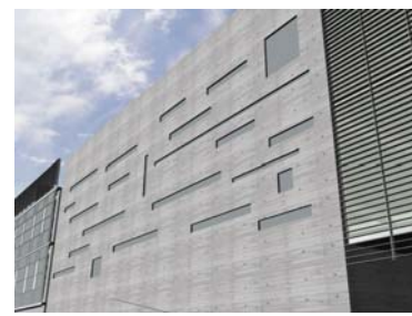
muro de concreto + biblioteca
