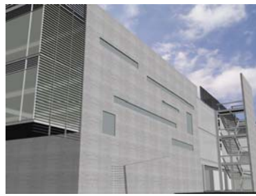
muro de concreto + biblioteca
