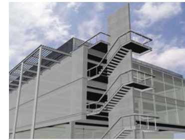
escalera de emergencia
