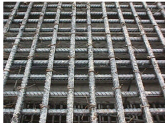
Fig. 3.7. Acero de refuerzo convencional, sin óxido
