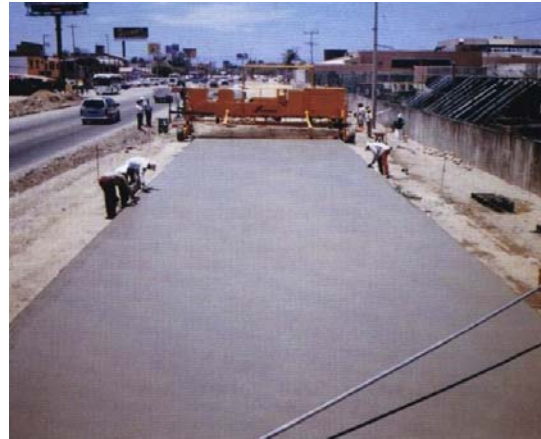
Fig.1.7. Pavimento hidráulico en construcción. Fuente: Obras, mayo, 2003.
