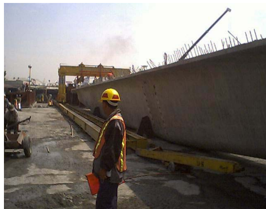
Fig.7.5 Viga presforzada (ballena) en planta de prefabricación. Una vez descimbrada la viga se traslada al sitio de la obra para su montaje. Distribuidor Vial San Antonio, Ciudad de México, 2003.
