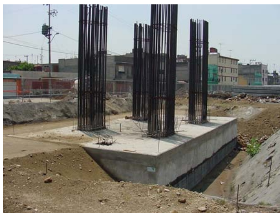
Fig. 1.6. Zapata de cimentación. Distribuidor Vial de Zaragoza. Etapa de Construcción. Ciudad. de México, 2002.
