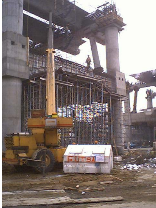
Fig. 7.4 Estructura de concreto presforzada. Distribuidor Vial San Antonio, Ciudad de México, 2003.
