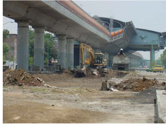
Fig. 1.8 Línea B del Sistema de Transporte Colectivo (Metro). Estructura de Concreto, Ciudad de México, 2002.
