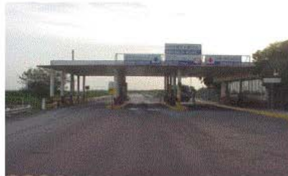
PUERTO FRONTERIZO NUEVA CIUDAD GUERRERO
