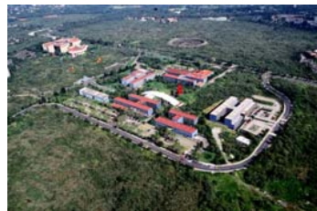
Vista aérea desde el sur-oriente del terreno y de los Institutos de Investigaciones.
