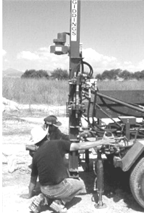
Fotografía 3. Nucleadora rotatoria "Giddings" realizando la extracción de material.
