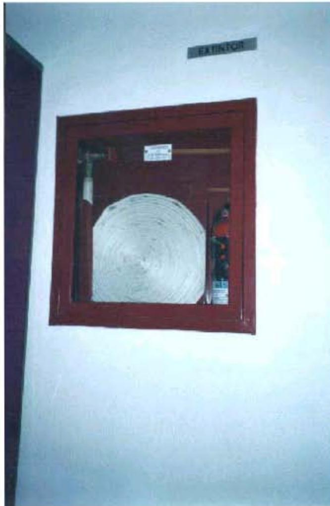
Fig. 29. Hidrante con extintor. Anexo de Ingeniería
