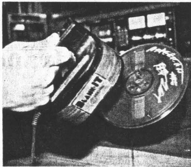
EL DESMAGNETIZADOR (parecido a una plancha), sirve para borrar las cintas que se utilizan en las estaciones radiofónicas y así poderlas regrabar.
