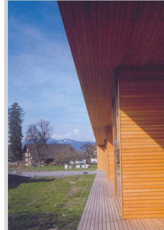
Vista del pasillo
