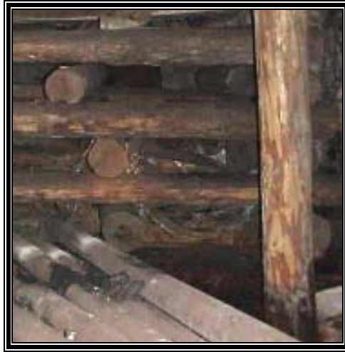
Fotografía 3.9. En la Mina III - MIMOSA se tiene como potencial contribución a la propagación del fuego la existencia de troncos de madera seca (monos). (Fuente: Mina III - MIMOSA).
