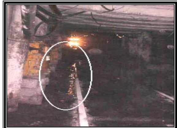
Fotografía 3.8 (a y b). Riesgo de fuego derivado del funcionamiento anómalo generado por un insuficiente mantenimiento de las instalaciones eléctricas.
