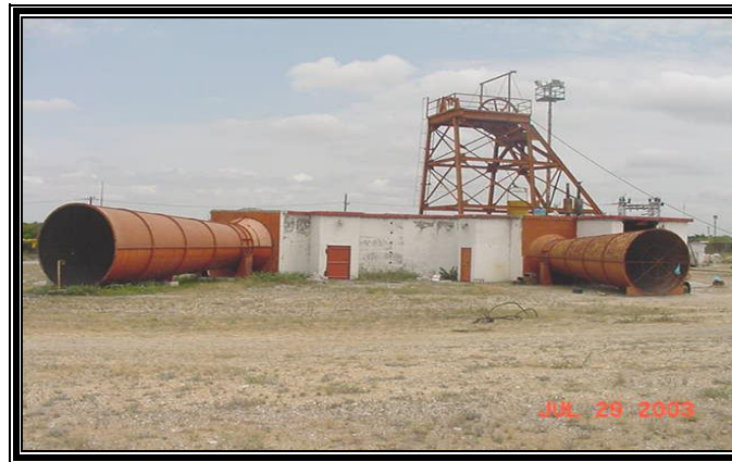
Fotografía 6.12. Vista general con ambos extractores. (Fuente: Mina III – MIMOSA).
