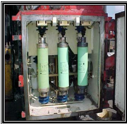
Fotografía 6.29. Fusibles del cofre.
