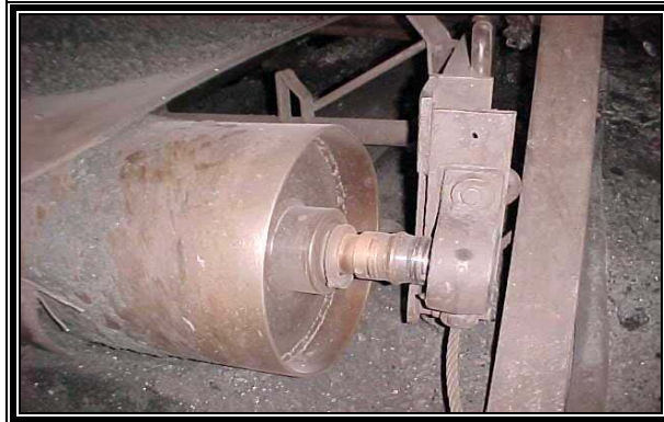
Fotografía A6.1. Rodillo de banda en cañón 6 oriente. (Fuente: Mina III-MIMOSA).
