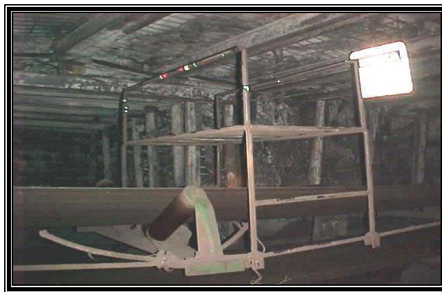
Fotografía A6.2. Se observa el centrado de la banda. (Fuente: Mina III-MIMOSA).
