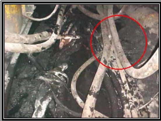
Fotografía 3.8 (a y b). Riesgo de fuego derivado del funcionamiento anómalo generado por un insuficiente mantenimiento de las instalaciones eléctricas.
