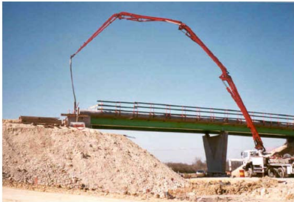
FOTO 2: BOMBEO DE CONCRETO AUTOCOMPACTABLE EN PUENTE
