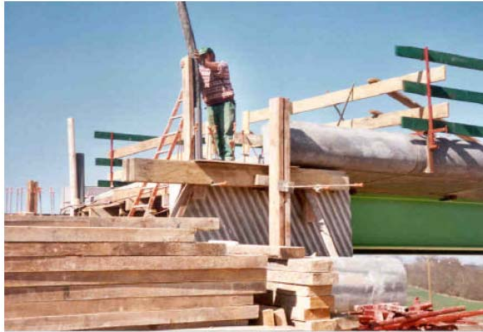
FOTO 1: COLOCACIÓN DEL CONCRETO EN CIMBRA
