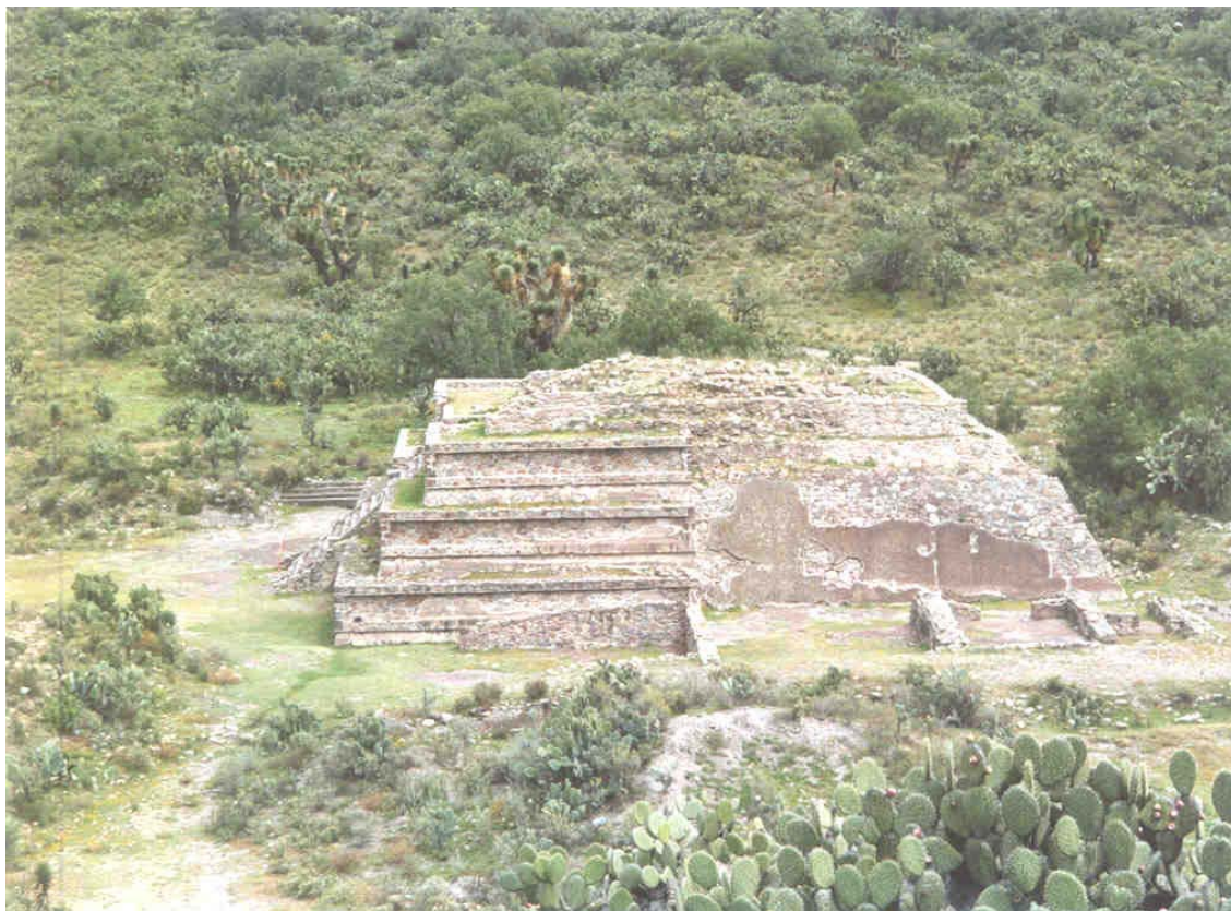
Fig. 20) Vista sur de la pirámide del Tecolote desde el cerro las Ardillas. (fotografía Juan Pedro Rivera)
