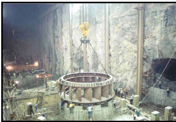
Fig.III.104.-Montaje del antedistribuidor en su sitio en una de las unidades de casa de máquinas
