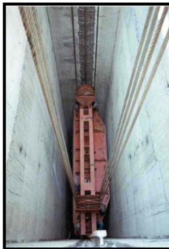
Fig.III.94.-Deslizamiento de la compuerta de cierre final
