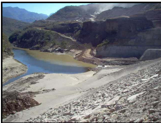
Fig.III.24.- Vista de ataguía aguas abajo, terminada
