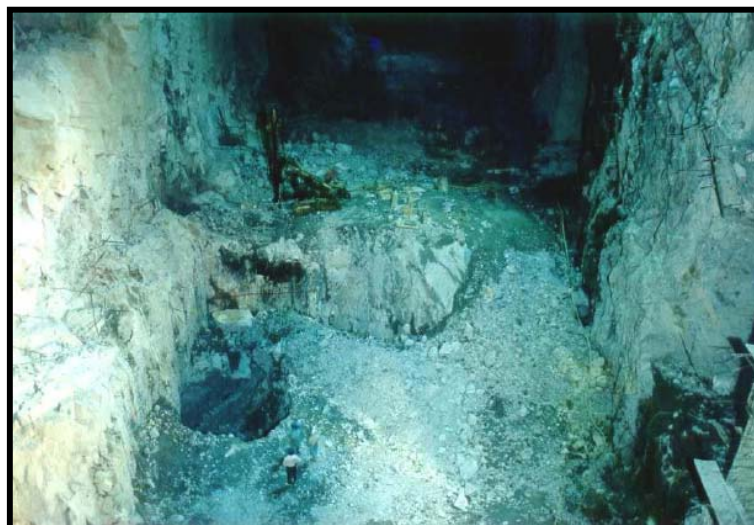
Fig.III.84.-Excavación de los fosos de las unidades de casa de máquinas
