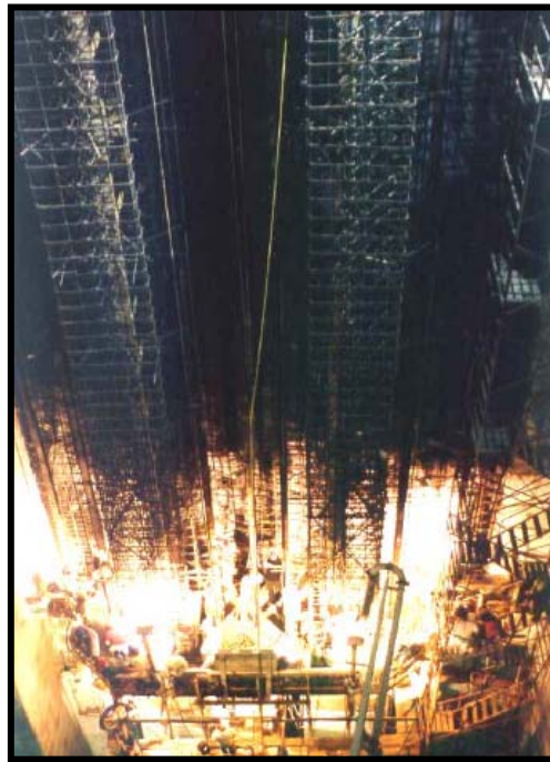
Fig.III.47.-Colocación de acero de refuerzo y colado en las guías de compuertas en pozos. Nótese el proceso de deslizado
