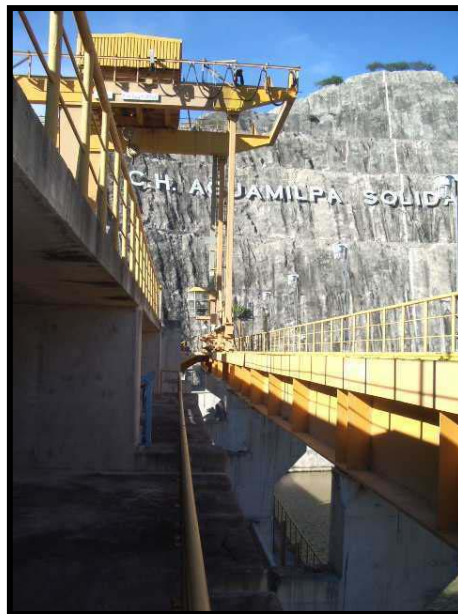
Fig.III.25.-Estructura de Toma en C.H. Aguamilpa, Nayarit
