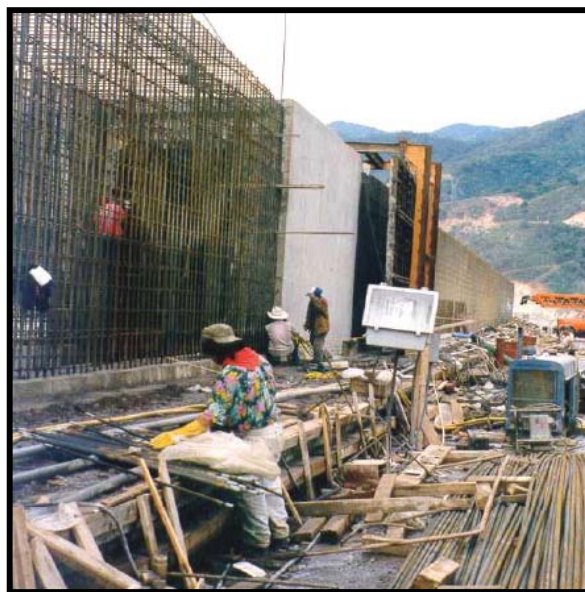
Figura III.74.-Construcción de muro divisorio del canal de descarga
