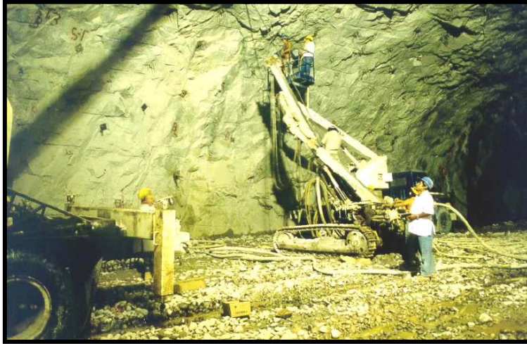
Fig.III.86.-Colocación de anclas con track-drill en la bóveda de casa de máquinas
