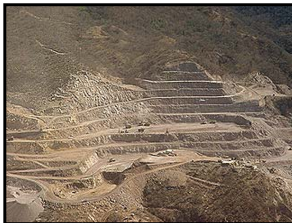
Fig.III.64.- Etapas definitivas excavación en canal de llamada
