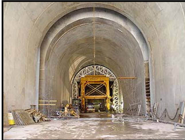
Fig.III.10.-Túnel 1 Obra de Desvío terminado
