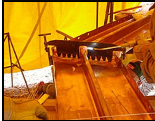
Fig.II.3.-Junta perimetral de cobre
