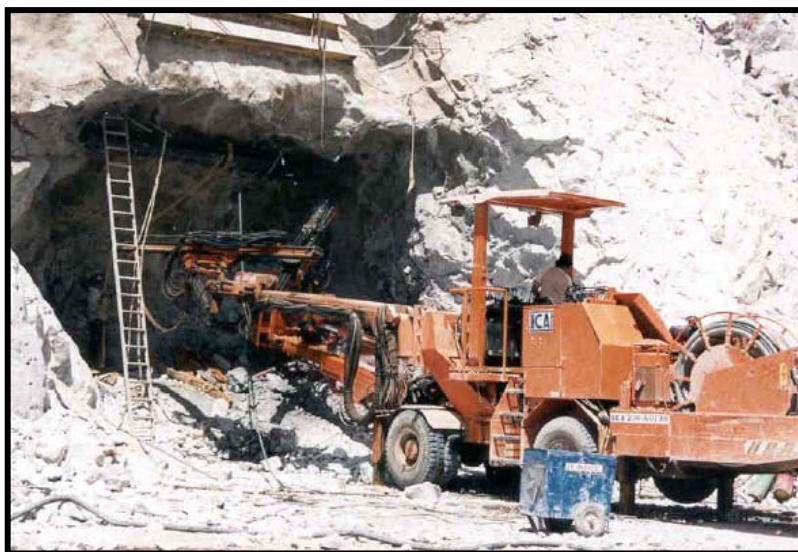
Fig.III.35.- Proceso inicial de excavación de las bocatomas
