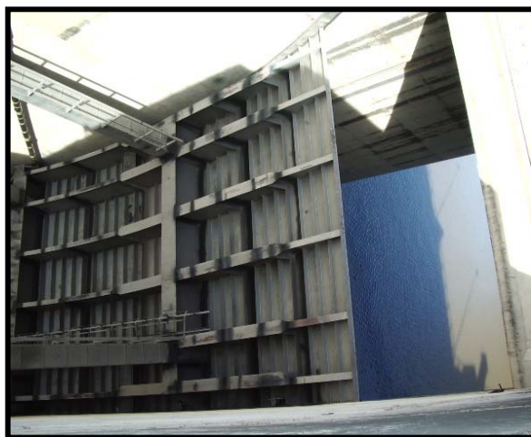
Fig.III.66.-Compuertas radiales, C.H. Aguamilpa
