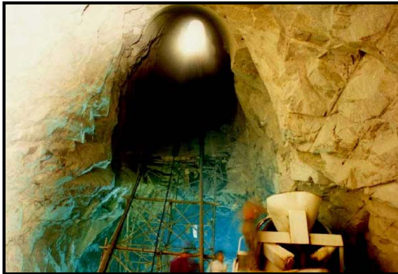
Fig. III.39.-Ampliación del pozo piloto de las tuberías a presión
