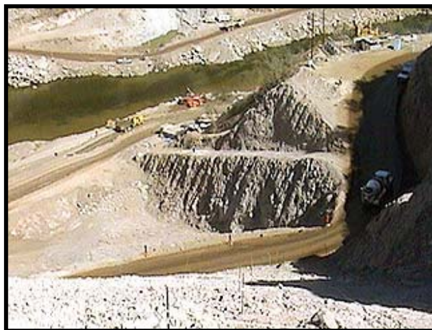
Fig.II.5.- Excavación del plinto margen izquierda
