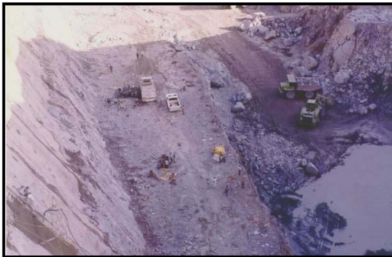
Fig. III.28.- Excavación del canal de llamada de la obra de toma
