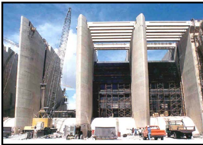
Fig.III.95.-Montaje de las compuertas radiales
