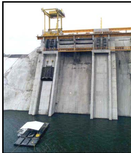
Fig.III.98.-Izaje de compuerta auxiliar con apoyo de grúa pórtico
