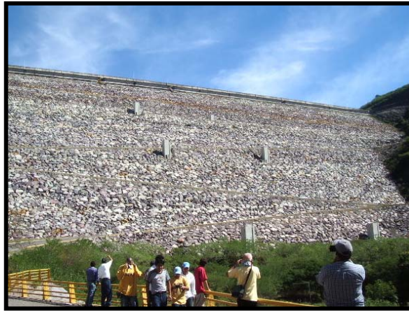
Fig.II.1.-Cortina de enrocamiento con cara de concreto, C.H. Aguamilpa, Nayarit
