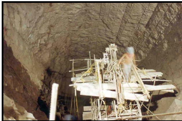
Fig.III.41.-Tratamientos de la roca en tuberías a presión, mediante uso de trackdrill montado en plataforma
