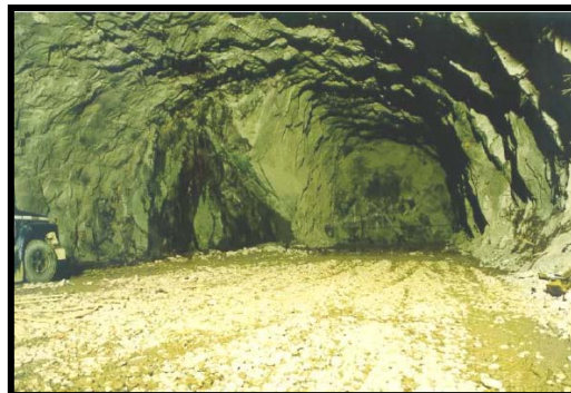
Figura III.45.-Excavación de la galería para izaje de compuertas
