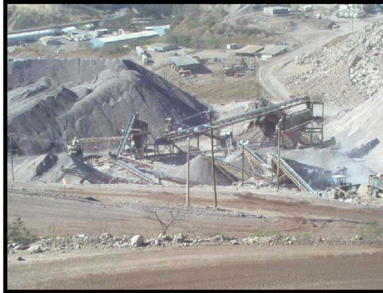
Fig.B-7. Producción de agregados para concreto, zona industrial del proyecto
