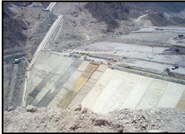
Fig.II.23.-Cara de concreto de la cortina
