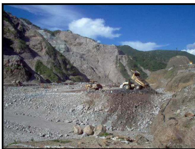
Fig.III.15.- Colocación de material para ataguía
