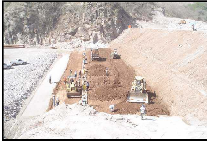
Fig.III.16.- Distribución y compactación de material en ataguía aguas arriba
