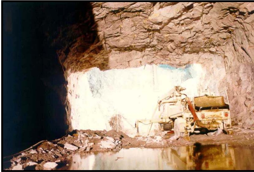
Fig.III.83.-Excavación de túneles de aspiración
