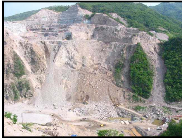
Fig.III.58.-Excavación canal de llamada
