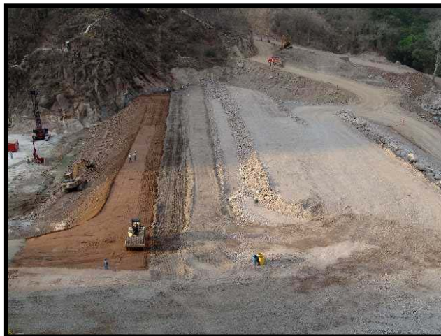
Fig.III.17.- Conformación de la ataguía aguas arriba
