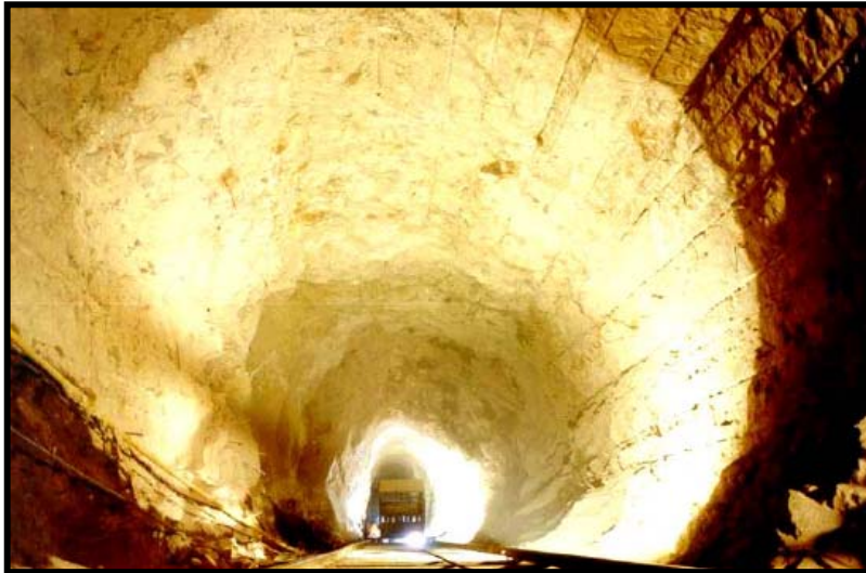
Fig. III.40.-Excavación a sección completa en tuberías a presión
