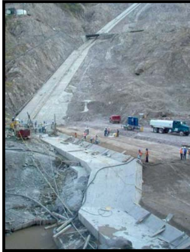
Fig.II.12.-Plinto Márgen Derecha visto de frente
