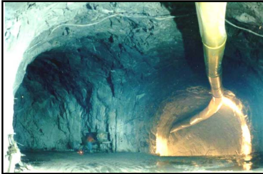
Fig.III.81.-Excavación de túnel auxiliar a tuberías a presión y tímpano norte de casa de máquinas
