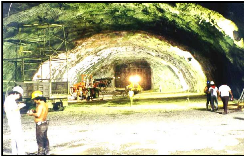
Fig.III.79.-Excavación de la bóveda de la caverna de casa de máquinas
