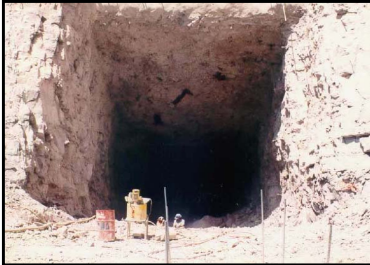
Fig.III.36.-Excavación del tramo bocatoma – transición – codo superior
