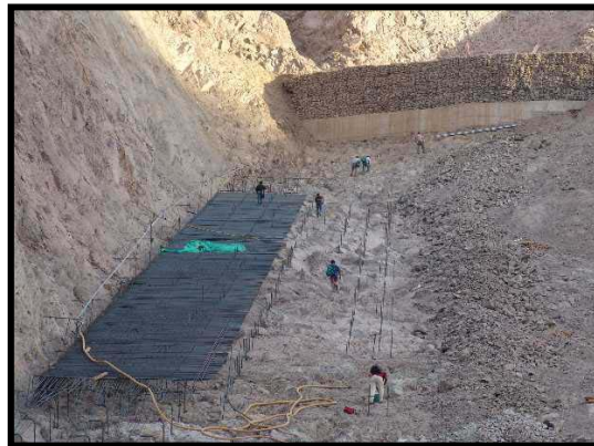
Fig.II.6.- Colocación de anclas en el plinto
