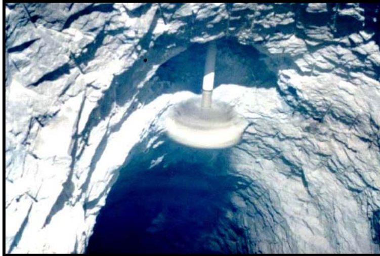
Fig.III.38.-Excavación del pozo piloto de las tuberías a presión con uso de máquina contrapocera. Nótese la rotación de la rima
