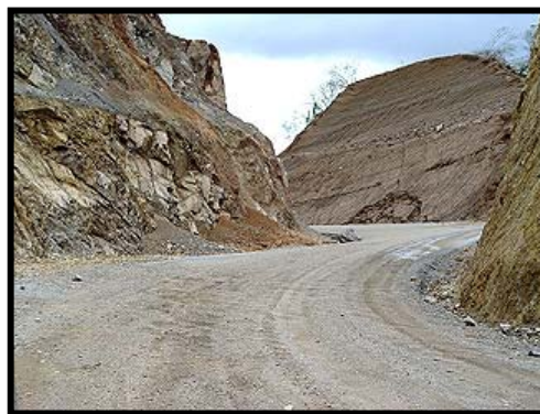
Fig.B-2. Caminos de acceso a la zona del proyecto y banco de materiales
