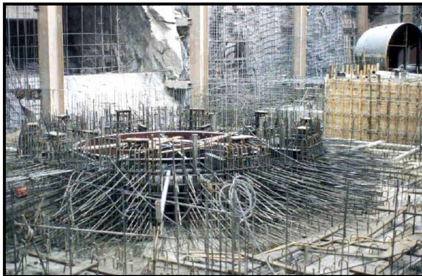
Fig. III.90.-Proceso de colocación de acero de refuerzo en fosos de generadores
