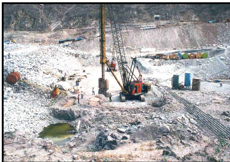
Fig.III.23.-Construcción de la pantalla flexoimpermeable con grúa almeja
