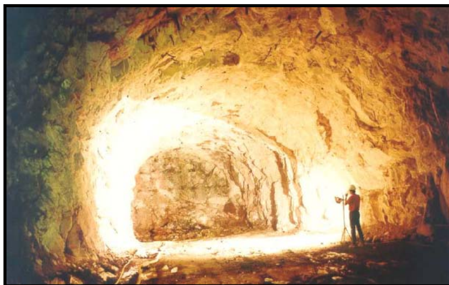
Fig.III.34.-Túnel de acceso auxiliar a tuberías a presión
