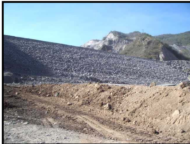
Fig.III.21.-Ataguía aguas abajo
