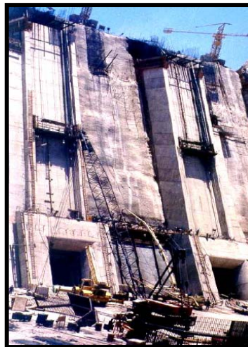
Fig.III.31.-Revestimiento en bocatomas y torres de compuertas
