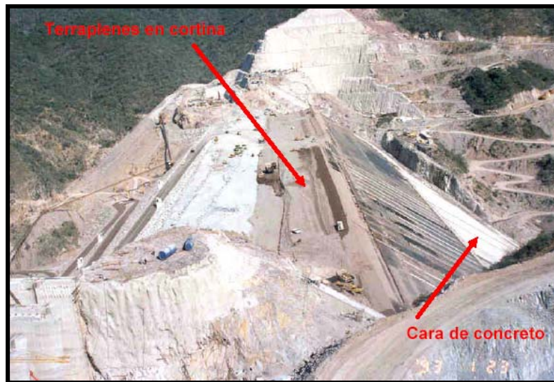
Fig.II.14.-Formación de terraplenes en la cortina. Nótese el proceso de construcción de la cara de concreto de forma simultánea
