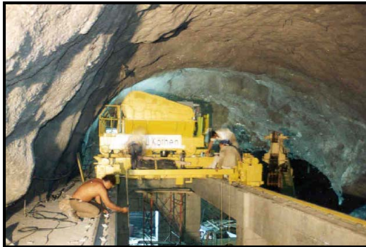
Fig.III.99.-Montaje del carro de la grúa pórtico sobre traves carril
