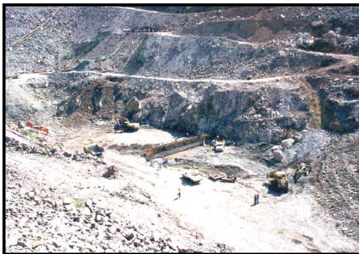
Fig.II.2.- Proceso de construcción del cárcamo de bombeo y limpieza del recinto de la cortina con retroexcavadoras
