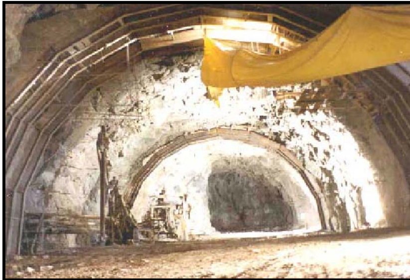
Fig. III.49.-Excavación de la bóveda del túnel de desfogue
