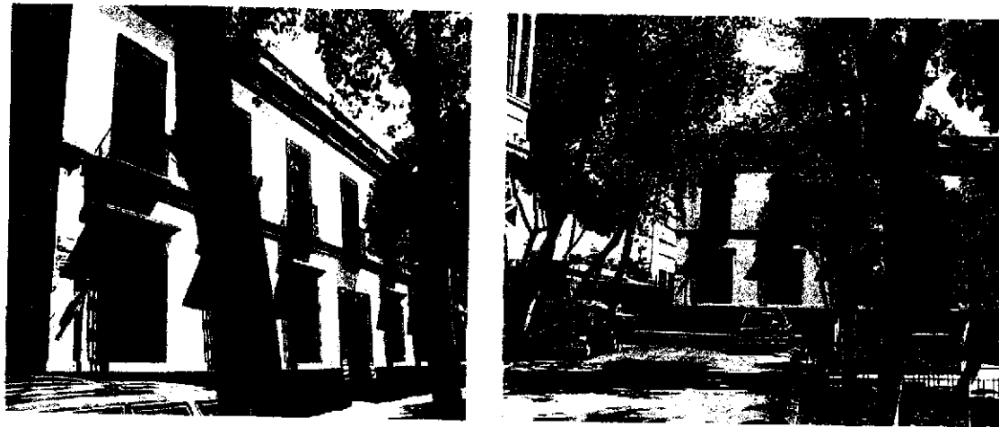
Vista de la fachada poniente del edificio catalogado
