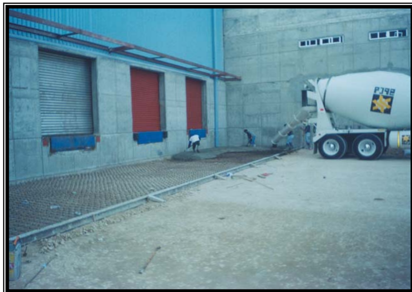
Colado de piso de concreto en patio de maniobras
