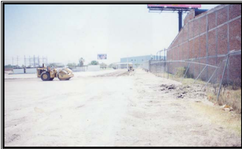
Compactación del terreno natural
