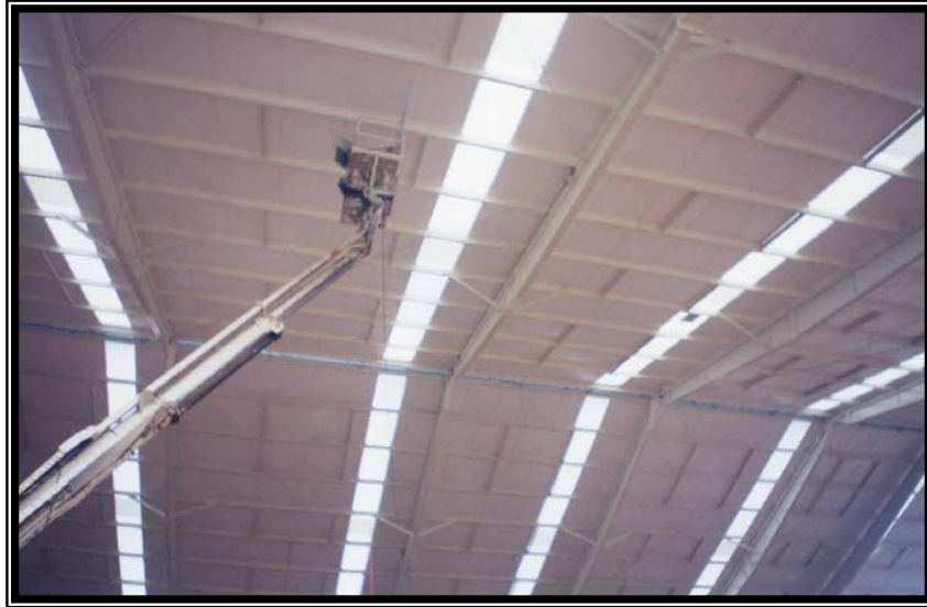
Canalización para instalación eléctrica
