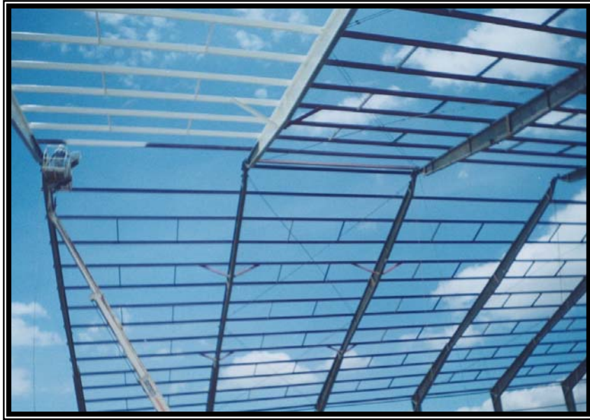
Aplicación de pintura en estructura metálica
