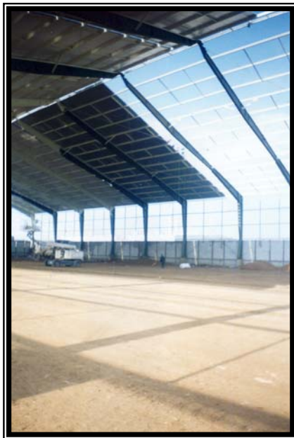
Colocación de aislante térmico
