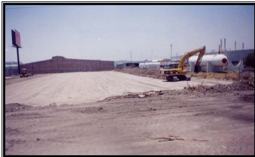
Excavación de cepas para zapatas corridas
