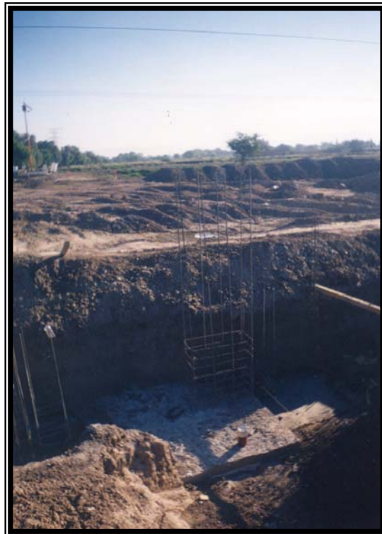
Colado de zapata aislada
