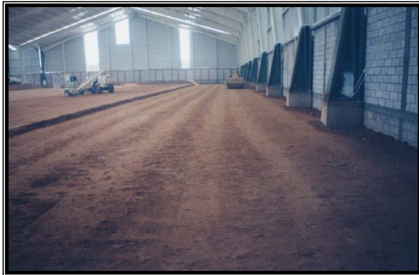
Compactación de tepetate para terraplén
