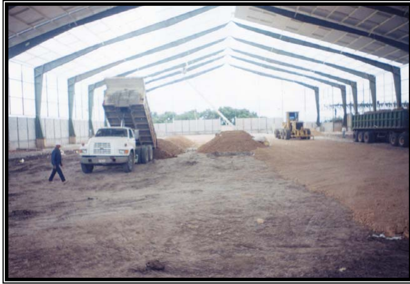
Tendido y nivelado de tepetate para terraplén
