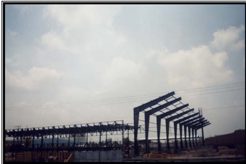
Estructura metálica de oficinas y nave principal
