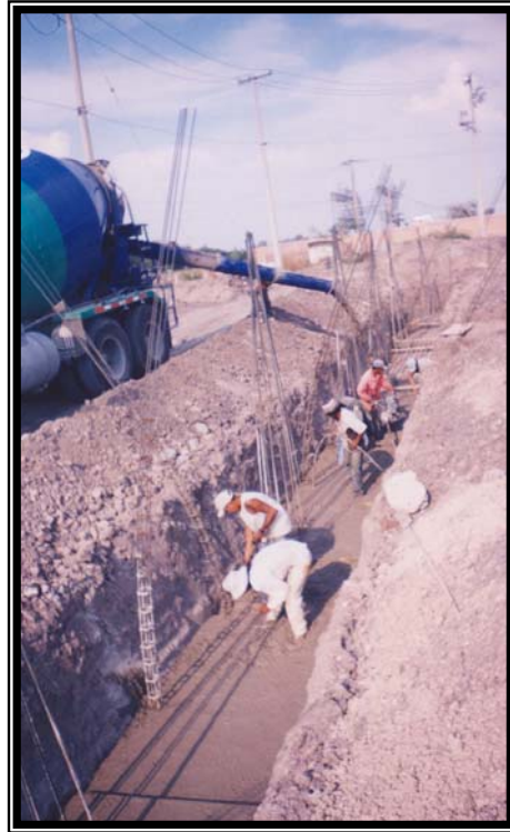
Colado de zapata corrida
