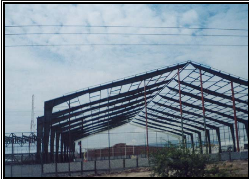
Conclusión de estructura metálica
