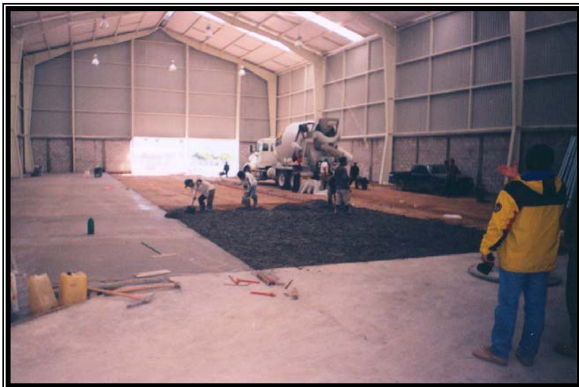
Construcción de pisos de concreto
