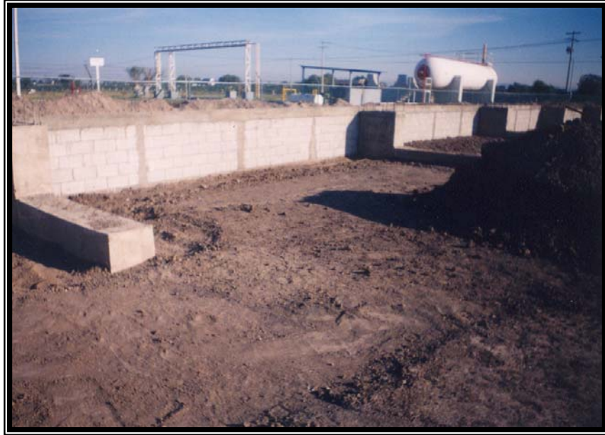
Cimentación y muro de contención
