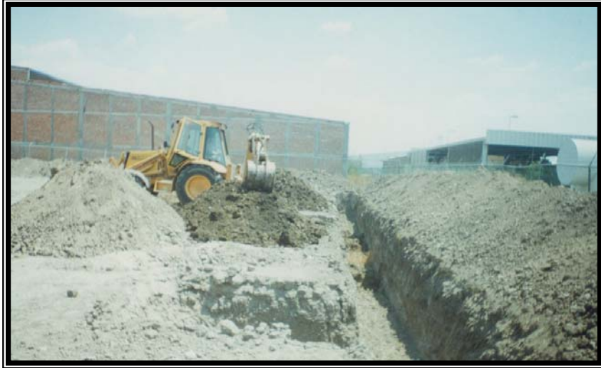
Excavación de cepas para zapatas aisladas
