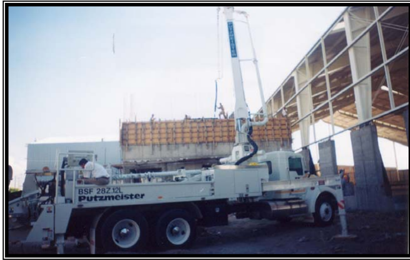
Colado de muros en edificio de servicios
