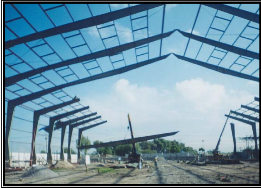
Colocación de marcos y montantes en nave principal
