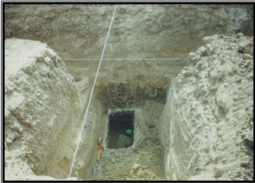
Excavación de cepas para prolongación de dados
