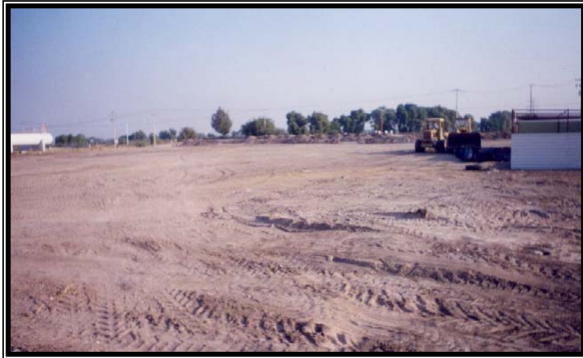
Despalme de terreno
