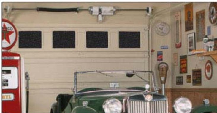
**Figuras 2 a y b : Elevador electromecánico I-drive para puertas con resortes de torsión. ( Wayne Dalton Corp. I-Drive Garage Door Opener, Ohio, 2003 ).**
