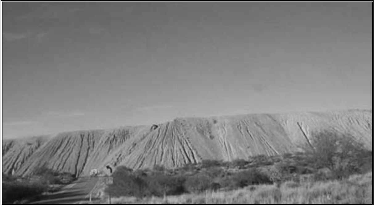
Figura 13. Evidencia de Erosión Eólica sobre la ladera (talud) de una Presa de Jales.
