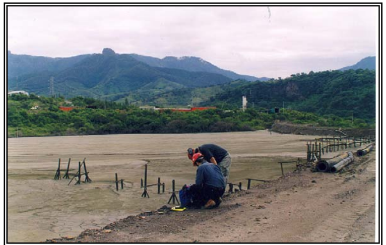
Figura 43 Panorámica de la presa de jales del Estado de México
