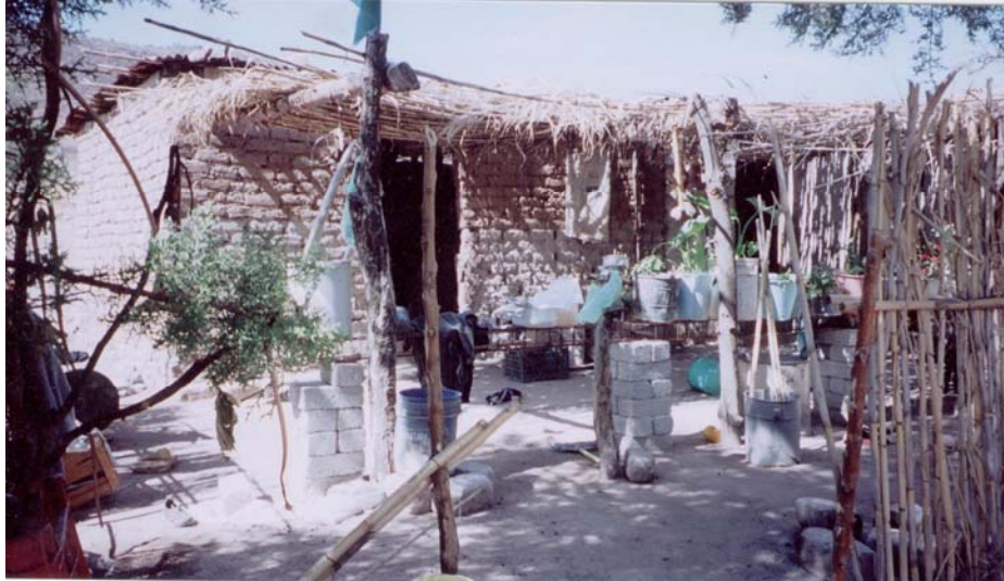
Fig. 13. Vivienda con muros sin aplanado y techo no de cemento
