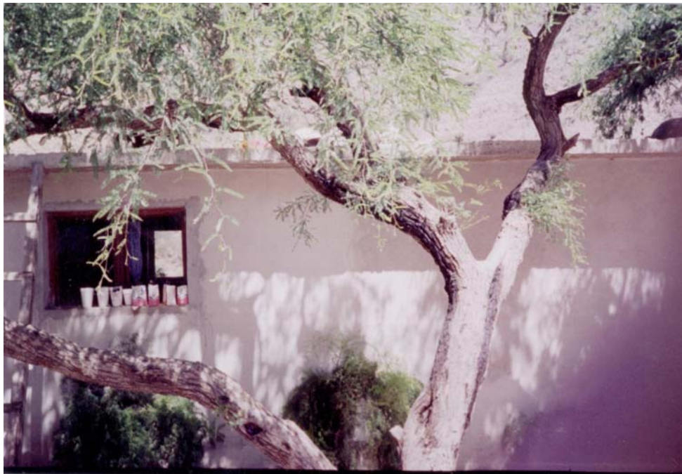
Fig. 12. Vivienda con muros con aplanado y techos de cemento
