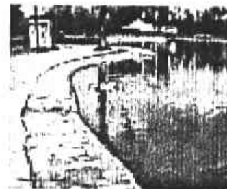
Los lagos artificiales no cuentan con alguna guarnición de protección
