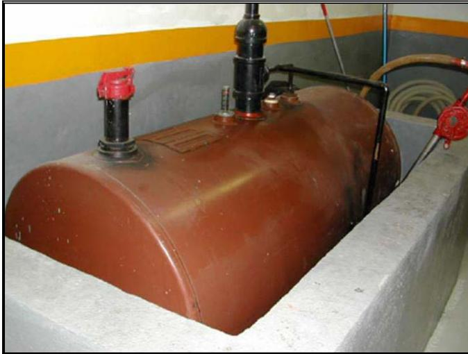
**RSG-03** Los equipos principales no se identifican en campo (TAG), no se respeta el código de colores establecidos en tuberías de conducción de fluidos, además los tanques de almacenamiento de gas y diesel carecen de rombo de identificación de riesgos y capacidad.
