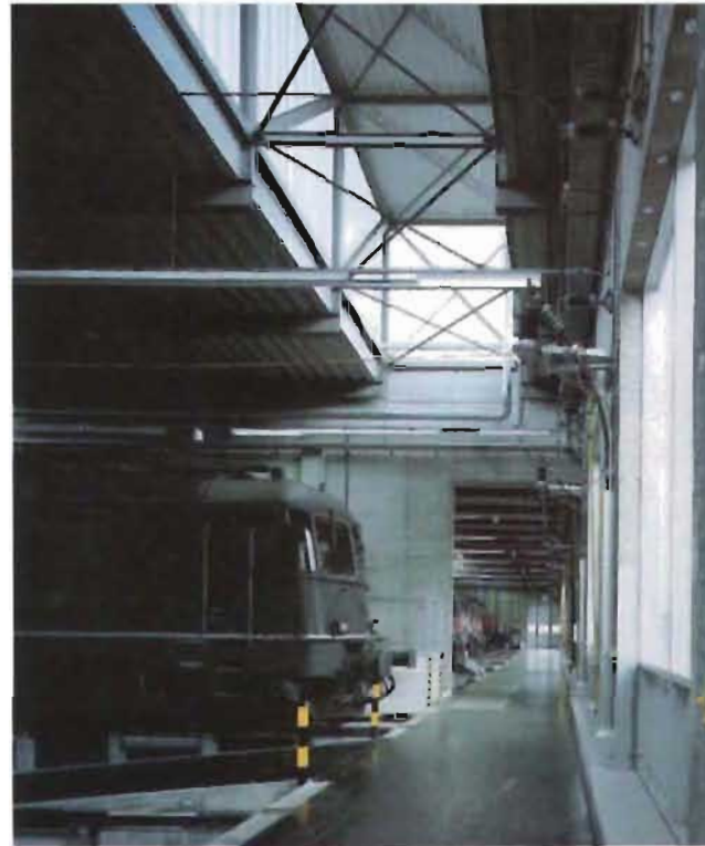
Foto 2 Depósito de locomotoras Auf dem Wolf Basilea, Suiza 1988-1996
