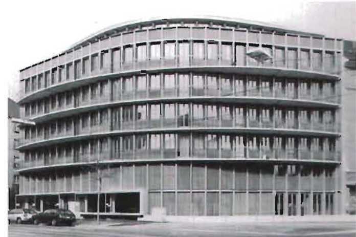
Foto 5 Edificio de apartamentos Schwitter Basilea, Suiza 1985-1988
