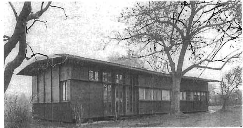
Casa de madera contrachapada en Bottmingen, Suiza.
