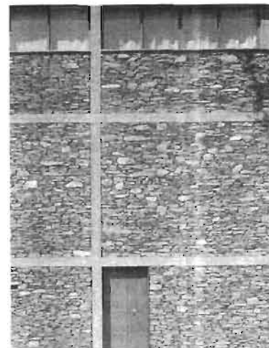
Casa de piedra
