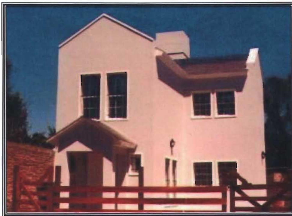
Ejemplo de Fabricación de Estructura de Acero para vivienda (Casa Villacastels). Fuente 80
