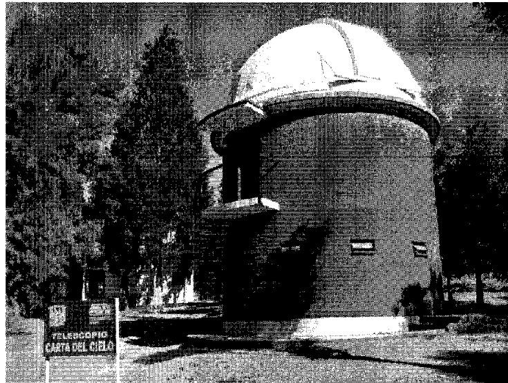
Figura 3.1: Edificio del telescopio Carta del Cielo
