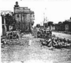
DEMOLICIÓN total de la capilla de San Bartolo.
