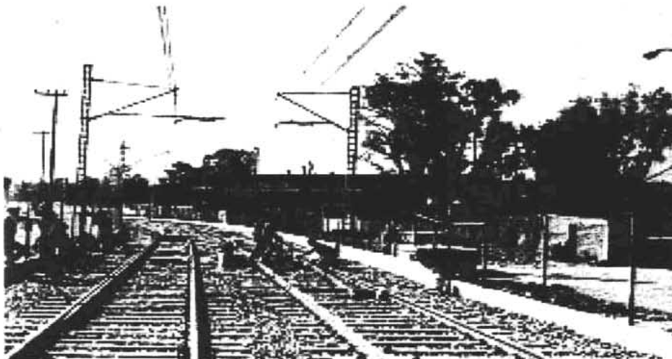
Figura 3. Colocación de los durmientes.
