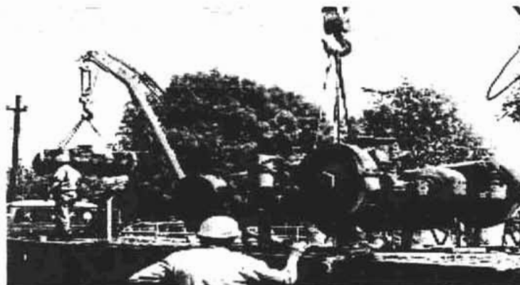
Figura 12. Colocación de los boogies.
