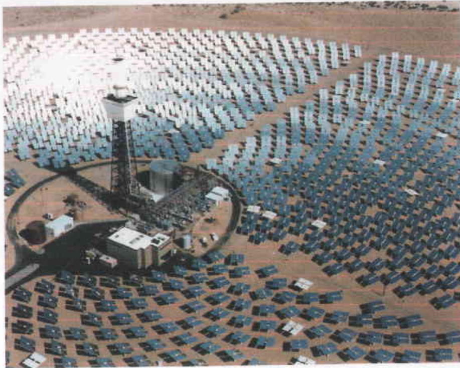
Figura 4.20. Este tipo de instalaciones puede operar 65% del año sin la necesidad de un sistema combustible de respaldo, proporcionando así, cientos de megawatts de energía limpia y renovable. Entre las distintas tecnologías que aprovechan la energía del Sol, las de concentración solar son las que ofrecen el costo más bajo para la generación de electricidad a gran escala.
