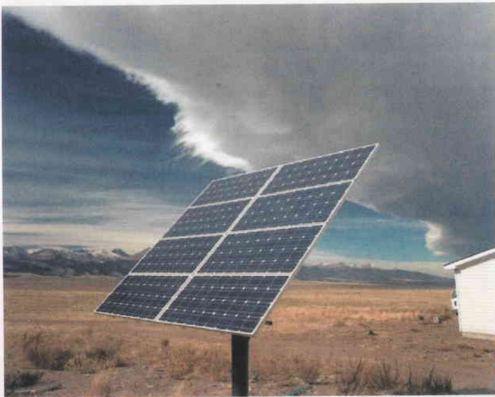
Figura 4.25. Los paneles fotovoltaicos pueden ser colocados con una inclinación fija, o pueden ser acoplados a un mecanismo de seguimiento de la trayectoria del Sol, con el objetivo de captar un máximo de la radiación solar a lo largo de todo el día.
