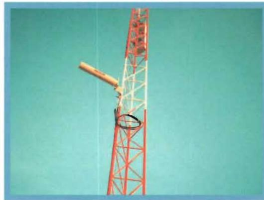
Foto 5. Antenas direccionales tipo yagui
