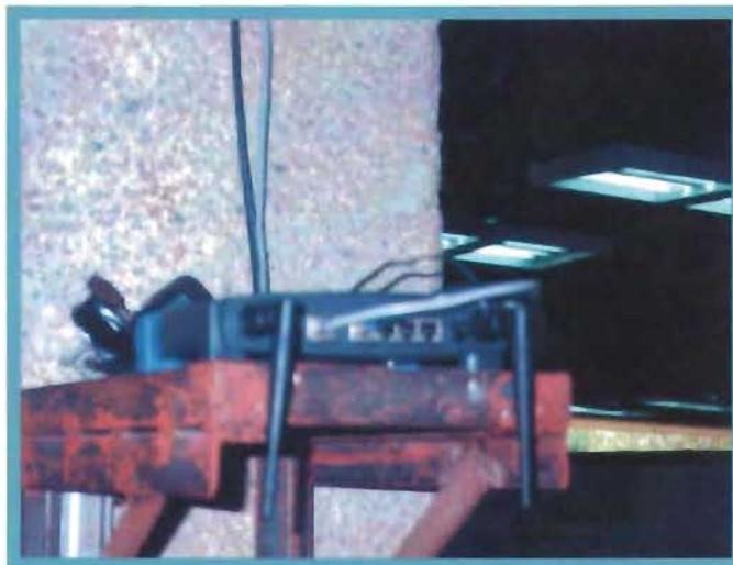
Foto 13. AP 1 montado en la base y en el pilar.
