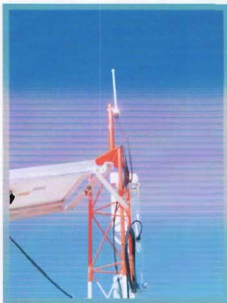
Foto 8. Antena omnidireccional.
