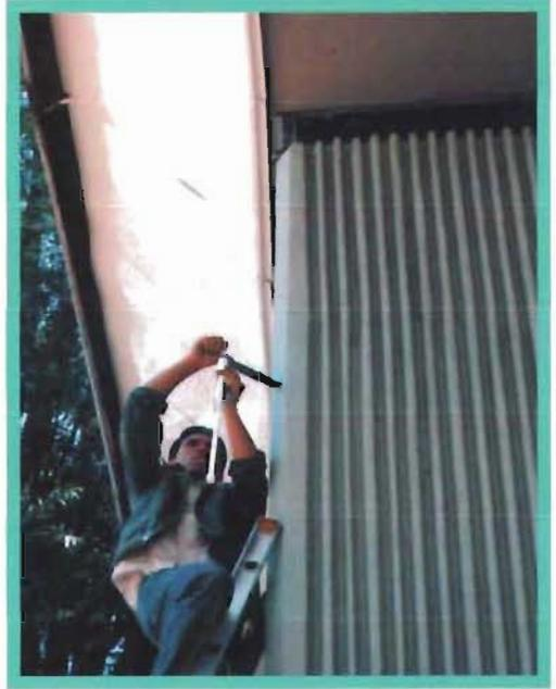
Foto 9. Cable coaxial LMR-400 que atraviesa el muro por el plafón en el techo del edificio.
