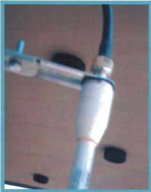
Foto 4. Conector Tipo N del coaxial a la antena.
