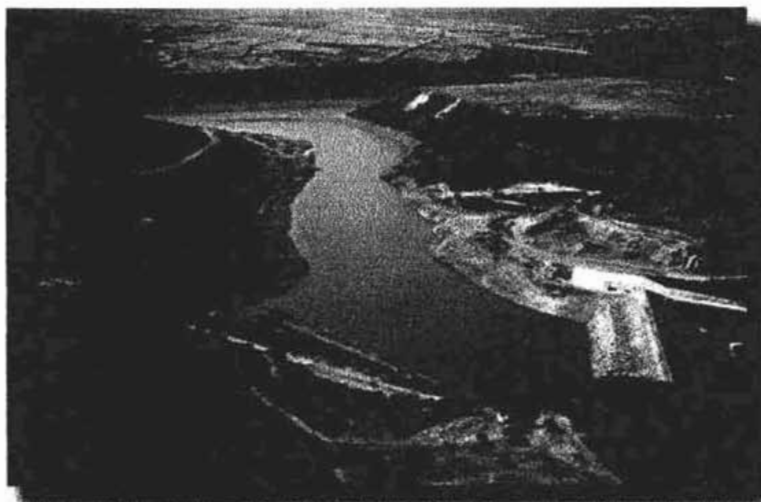
PRESA EL BAIAN.
