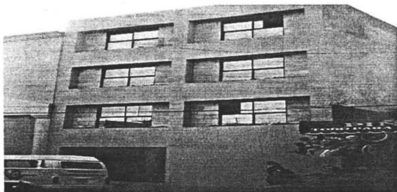
Imagen 7 Instalaciones anexas al edificio principal del plantel Ángel de la Independencia del nivel primaria.
