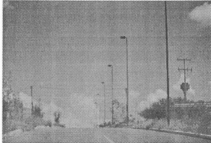
Foto 7.- Acceso existente del lado poniente, el cual esta terminado
