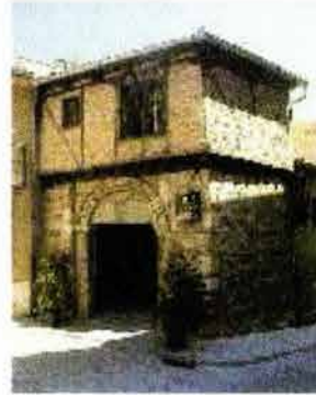
Fig. 52.- fachada posterior acceso de servicio
