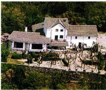
Fig. 57.- Vista aérea de fachada principal.
