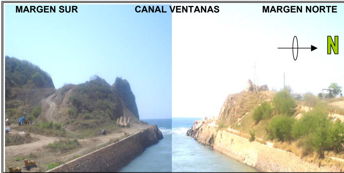
Fotografía 1. Vista de las márgenes Sur y Norte
