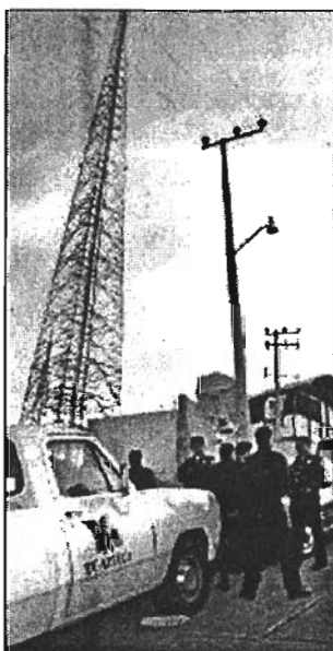
Instalaciones del Canal 40 en el Cerro del Chiquihuite
