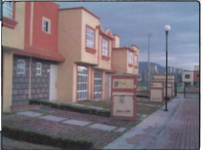
Interior de Privada
