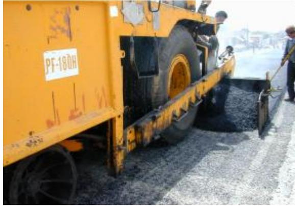
4. Concreto con asfalto ahulado. De granulometría abierta (Open Graded), media (Gap Graded) o cerrada (Dense Graded) según su diseño.
