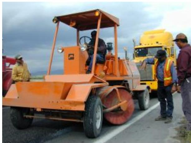
Antes de la colocación de la capa de sello sobre asfalto-hule caliente, polvo y en otros materiales serán removidos de la superficie de pavimento.
