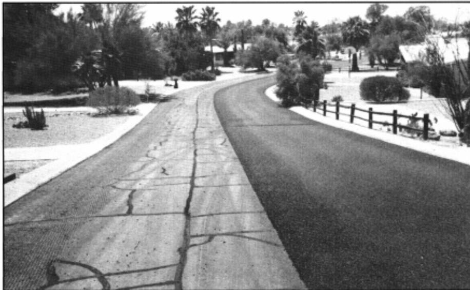
Foto: Sobrecapa con hule-asfalto en caliente, condiciones antes de colarla en el lado izquierdo y capa colocada en el lado derecho.
