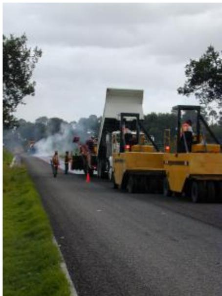
3. Refuerzo de Pavimentos. Una membrana intermedia de absorción de esfuerzos llamada SAMI (por las siglas en inglés de Stress Absorbing Membrane Interlayer).
