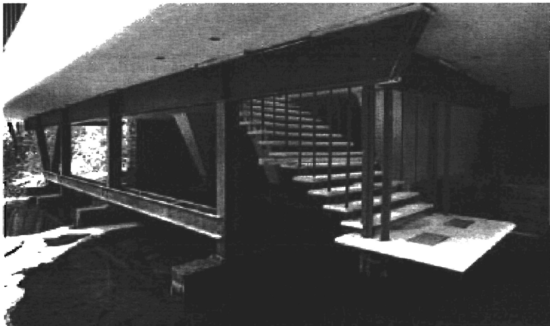
Soporte emergente de la terraza principal que, en “cantiliver”, se ubica sobre la caída de la cascada.
