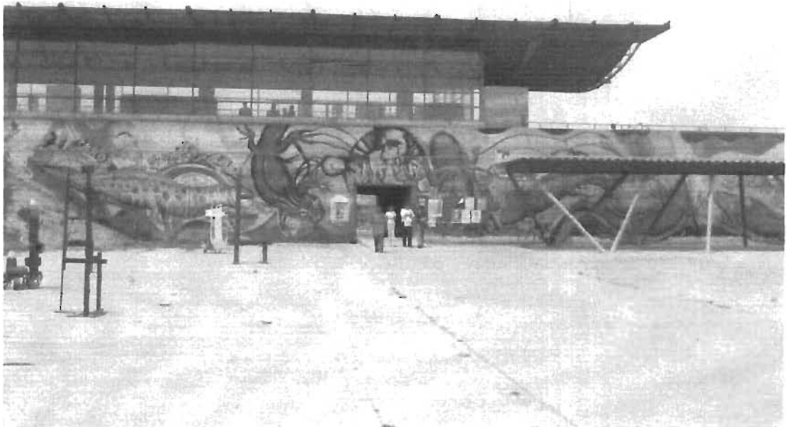
Foto: Plaza pública del Faro de Oriente
