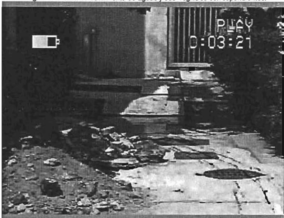
Imagen 5.- Base de tanque elevado. Fugas y registros destruidos.
