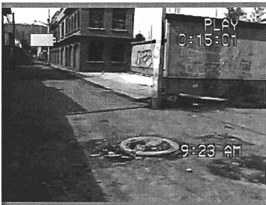
Imagen 5.- Drenaje existente y su nulo mantenimiento, en este caso a los registros.
