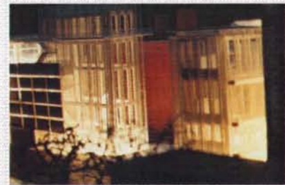
Edificio Museo y Anexo Fachada José Ma. Marroquí
