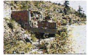
Construcciones en zonas de recarga del manto acuífero
