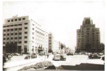
Vista del edificio de la Nacional, primer rascacielos de la ciudad
