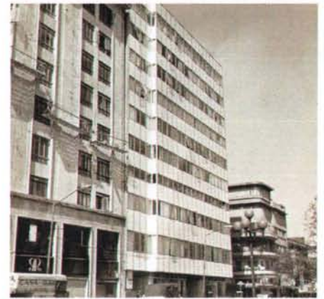
Edificio Salinas y Rocha, derrumbado en el sismo de 1985
