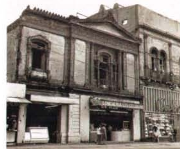
Fachada de inmueble de patrimonio
