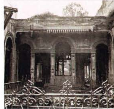
Interior de inmueble en estado de deterioro
