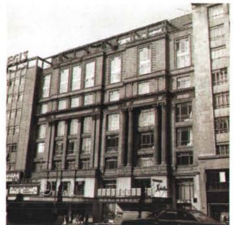
Hotel Regis, derrumbado en el sismo de 1985
