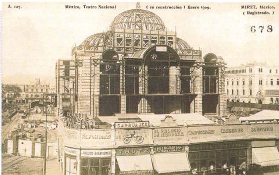
< Vista del palacio de bella artes en proceso de construcción en el año de 1909
