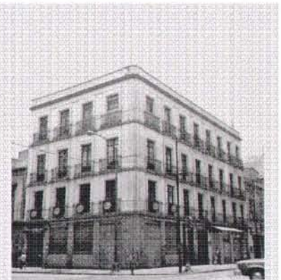
Edificio de oficinas
