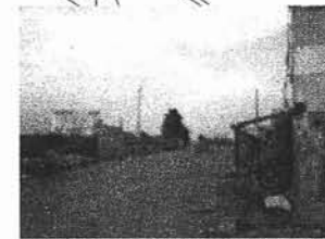
F11. COLINDANCIA CON EL TIRADERO MUNICIPAL, NO HAY BARRA SÓLO LO LIMITA EL CAMINO DE TERRACERIA
