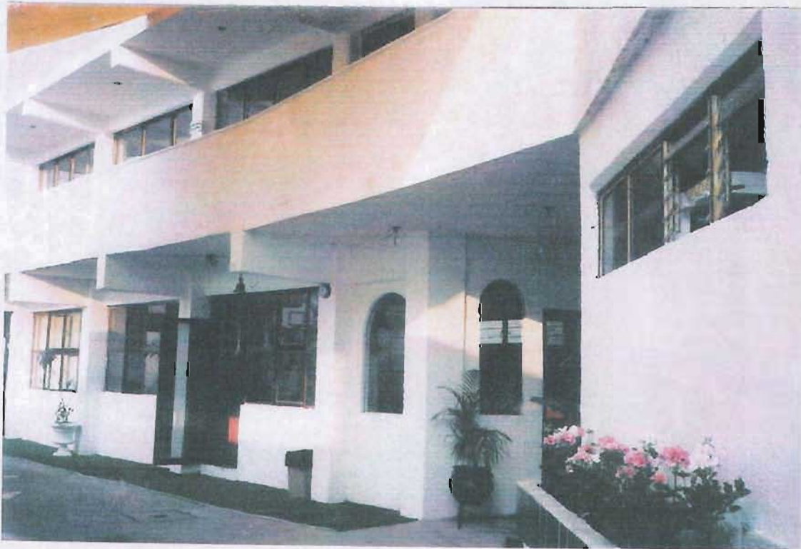
Foto 2: Edificio del "Instituto Villa del Sur"
