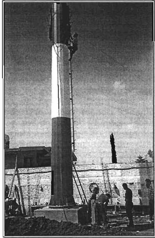
Figura 29. Manobra de retiro de gatos hidráulicos
