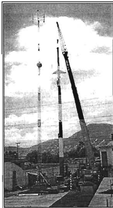
Figura 31. Acoplando 3er segmento
