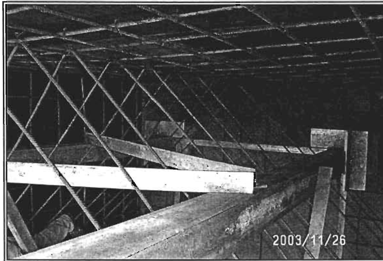
Figura 58. Habilitado, armado de acero de refuerzo y colocación de tramo "0".
