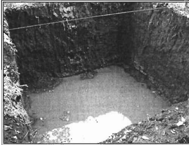
Figura 56. Excavación de cimentación.
