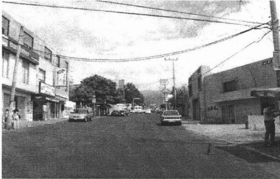
Foto 18. Vista de Av. Universidad pendiente abajo dirección al sur desde el cruce de la calle Narciso Mendoza con la misma.
