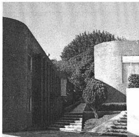
Edificio tipo de laboratorio del CCG
